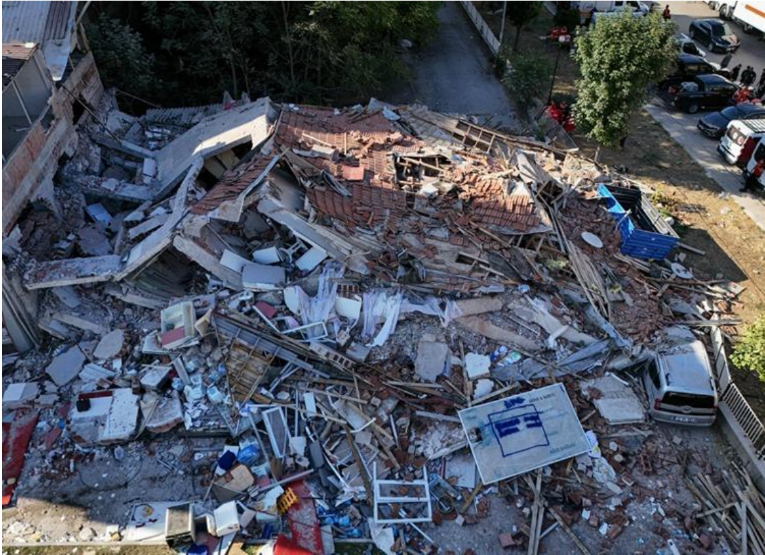
Şekil 3. 1. Sındırgı Camikebir Mahallesi’nde yıkılan binanın üstten görünümü
